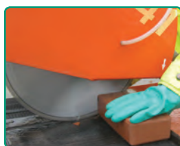
Przecinanie cegły przemysłowej
